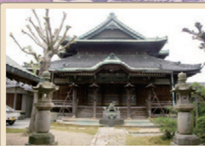
昭和19年(1944)東南海地震や台風で倒壊したとされる善光寺(飛島村)
