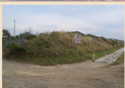
嘉永7年(1854)安政東海・南海地震による津波を契機に、貝やかきの殻を積み上げてつくられた津波除けの海岸堤防『かいがらぼた』(田原市)
