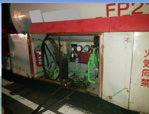
ガス回収作業①
