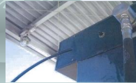
図4 緊急離脱カプラ及びガス抜きホース図
