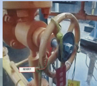
図5-① アンモニア貯槽 液面計 下部元弁
