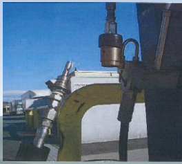
図4 緊急離脱カプラ及びガス抜きホース図
