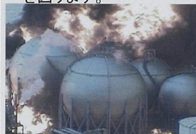
東日本大震災時に発生した大規模火災の様子
