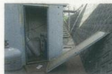
アルゴンガス置場①
