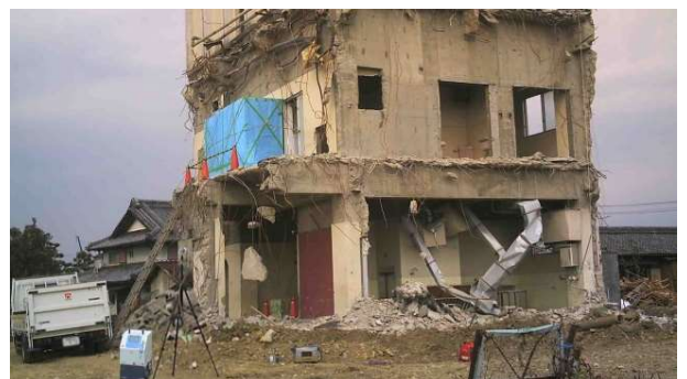
建築物解体現場の敷地境界でのアスベストの調査
