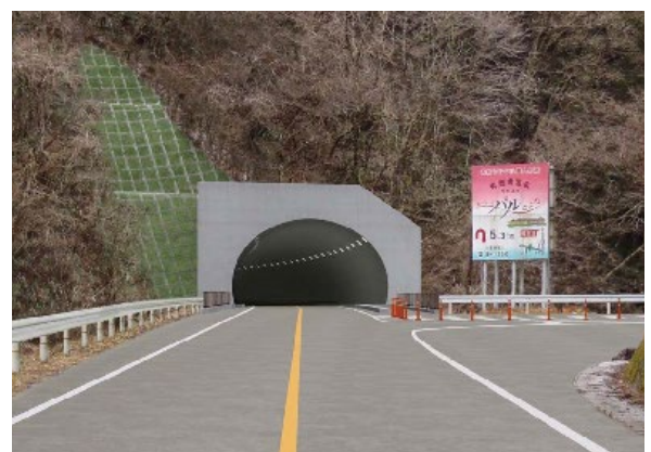
⑧ 国道151号太和金バイパスの整備推進 (太和金トンネル北側 (豊根村) 坑口付近 (イメージパース))
