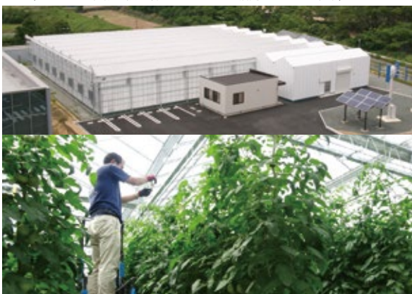
⑦ 「食農産業クラスター推進協議会」による植物工場等の推進 (植物工場における、空調・養液システム等を活用した高収量生産の実証実験)
