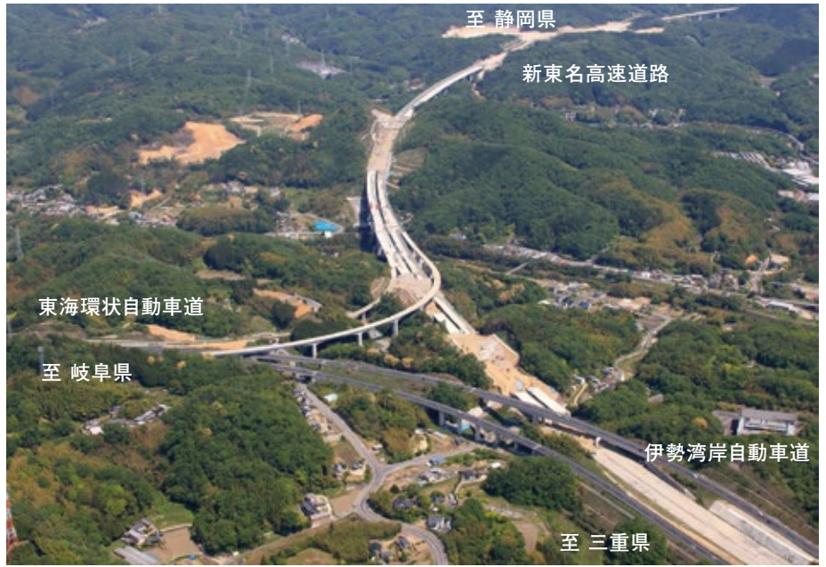
新東名高速道路 豊田東JCT～浜松いなさJCT(豊田東JCT 2014年5月)
