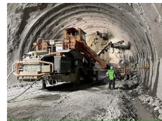
③西尾非常口・保守基地
