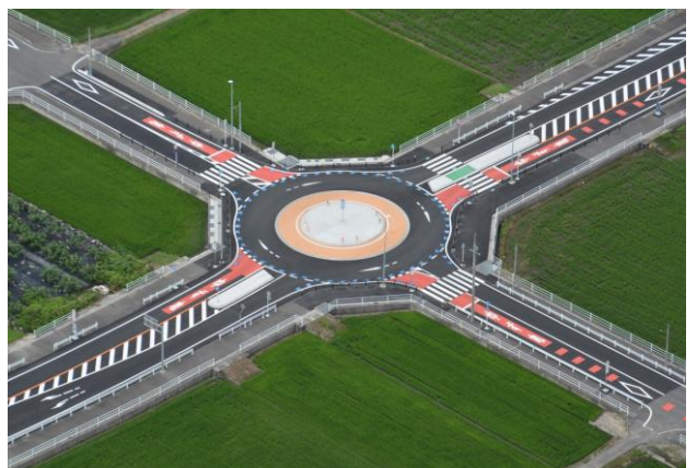
愛西市大井町地内 (東名阪自動車道北側)
