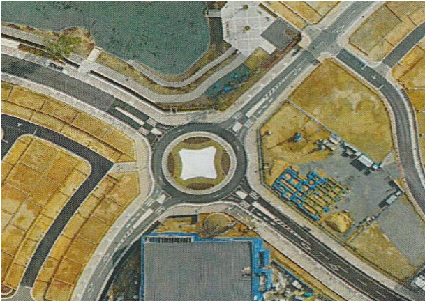
豊橋市曙町地内 (高師駅北東約900m)
