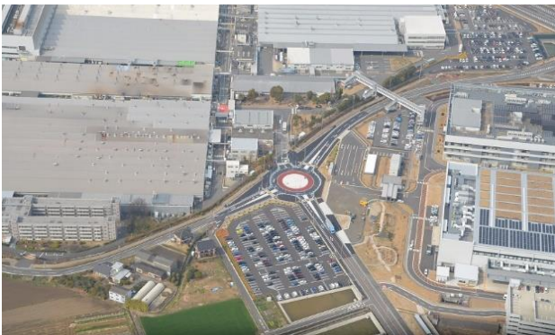
安城市里町長根地内 (新安城駅北約2000m)
