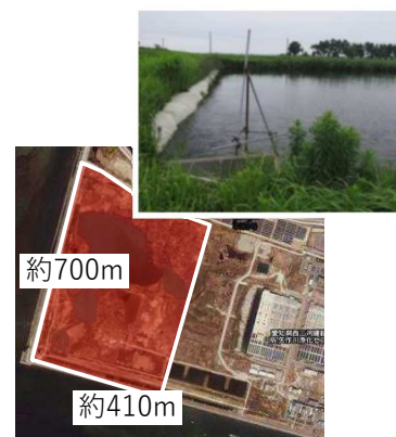
矢作川浄化センター
