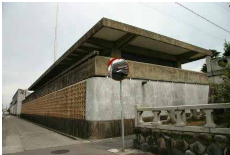
墨会館（北西から）
