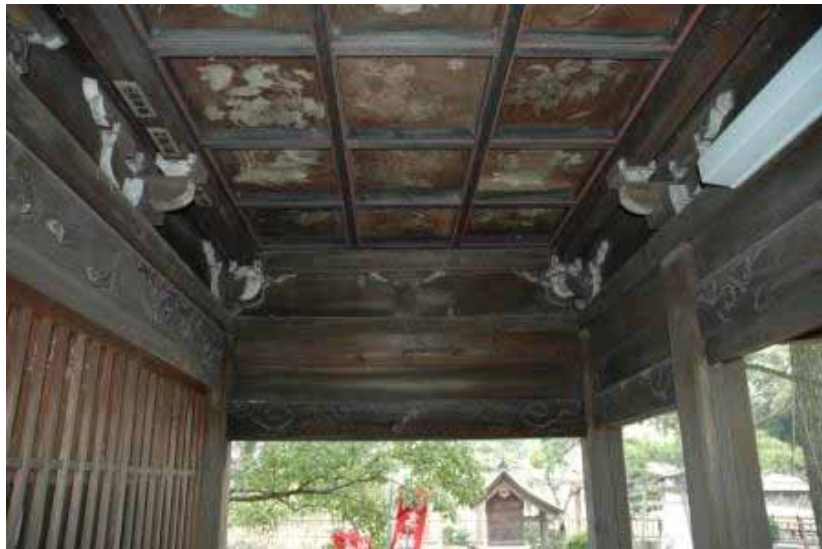
外陣の格天井
