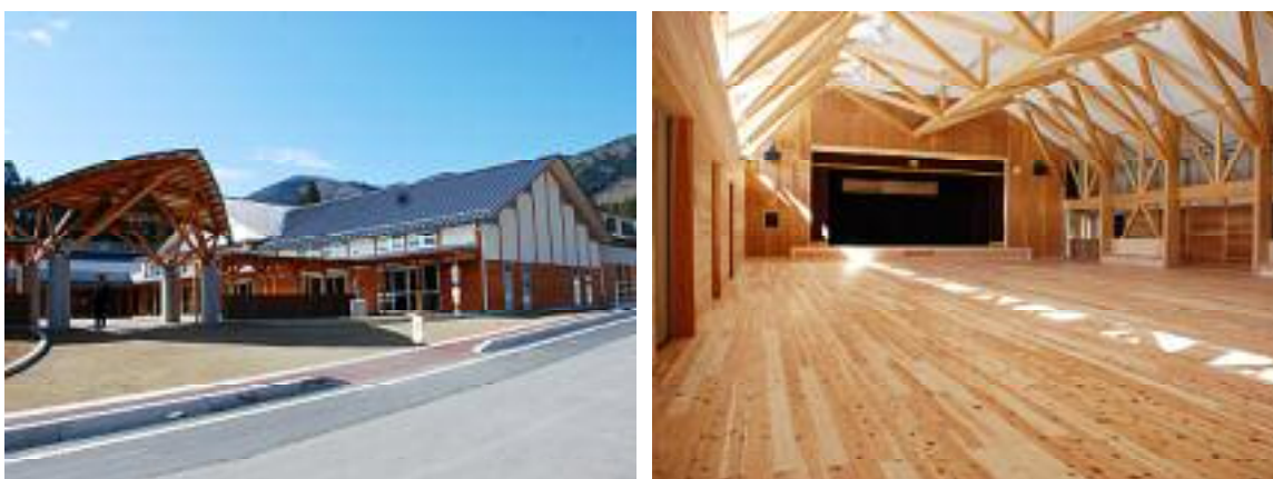
設楽町立名倉小学校の新校舎(平成20年3月21日完成) 右 外観 左 内部
