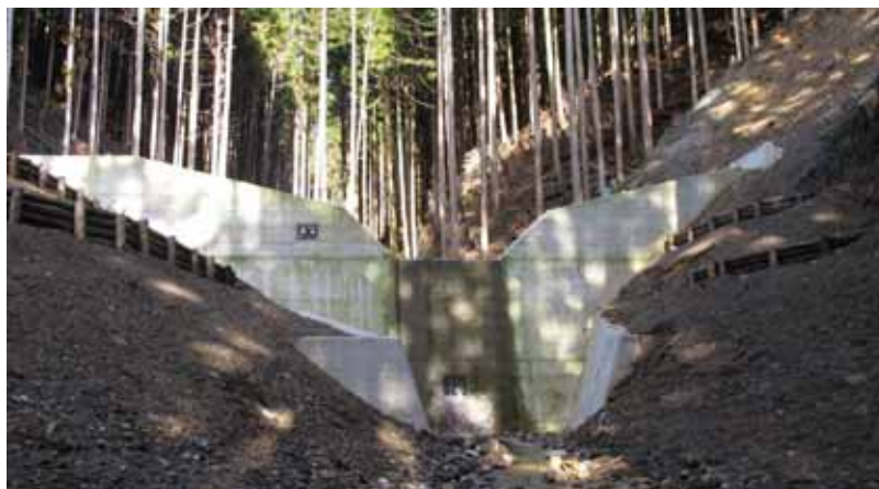
新たに整備された治山ダム(豊根村)
