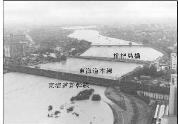
J R東海道新幹線庄内川橋りょう付近 【平成12年東海豪雨時】(名古屋市西区・清須市)
