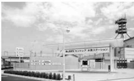
セントレア水素ステーション (東邦ガス(株)提供)
