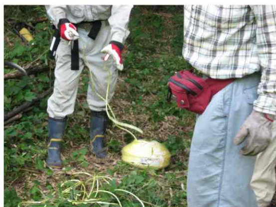
ロープにより作業区域を明確化
