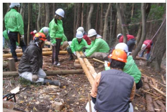
写真16 企業の社員による土留め作業
