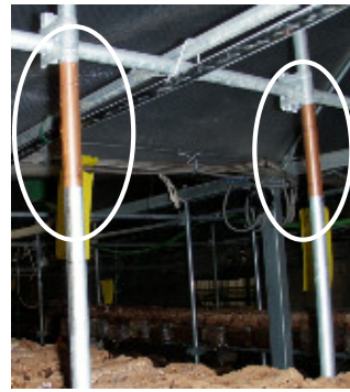
支柱上部の15cm巻きつけ
