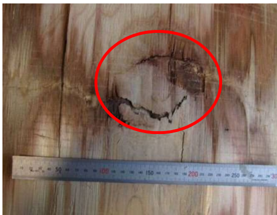
写真-2 横割れ状の「もめ」
