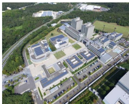
愛知県立大学の太陽光発電設備
