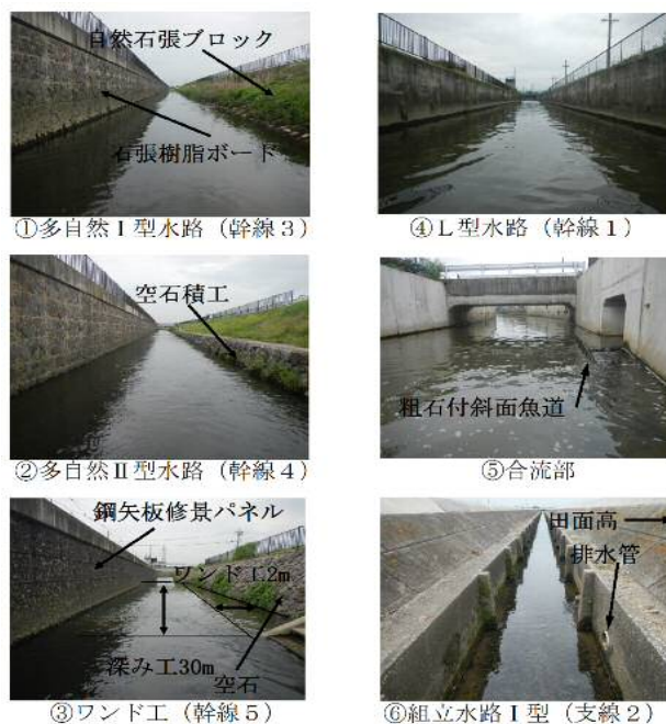
図2 各工法の写真(撮影日:2015年9月3日)
