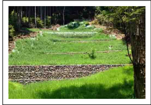
山地災害を防ぐ土留工
