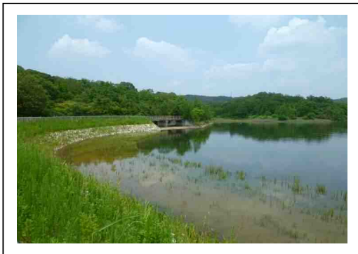
自然石護岸を採用したため池
