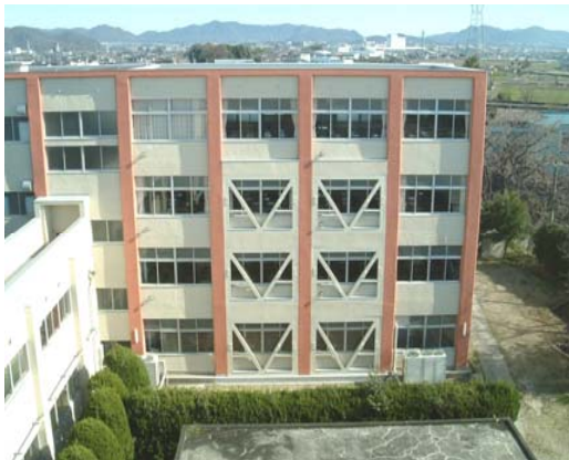
(耐震改修の事例)
