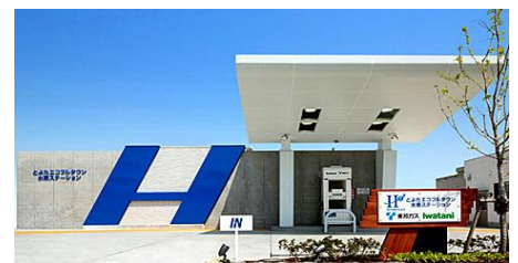
とよたエコフルタウン水素ステーション
