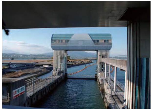
↑ 閘門(兼右岸ロック式魚道)
