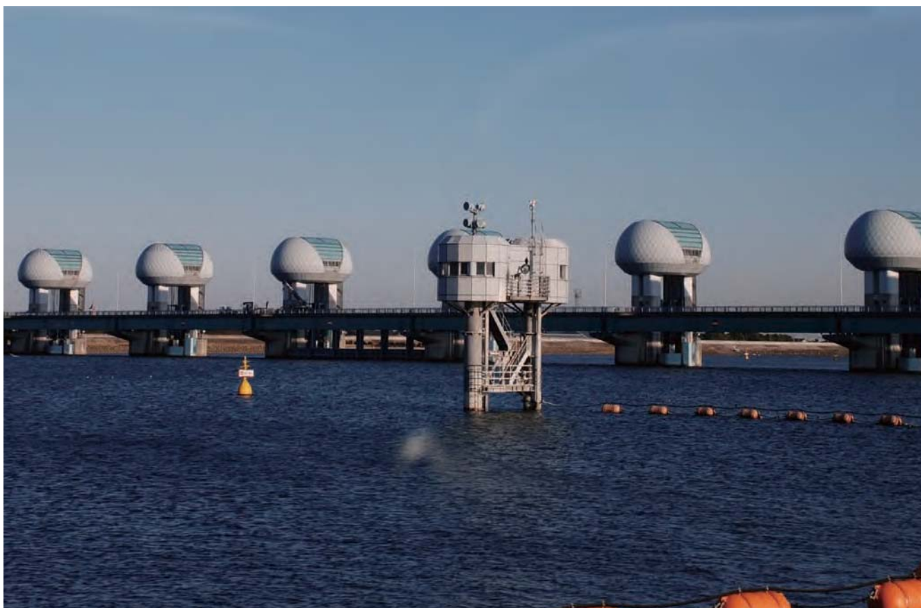
↑ 右岸上流から見た長良川河口堰 写真：森島裕美子(10ページも)
