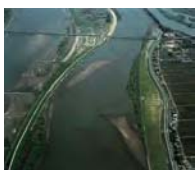
浚渫前のマウンド付近の状況 水機構長良川河口堰管理所ホームページより
