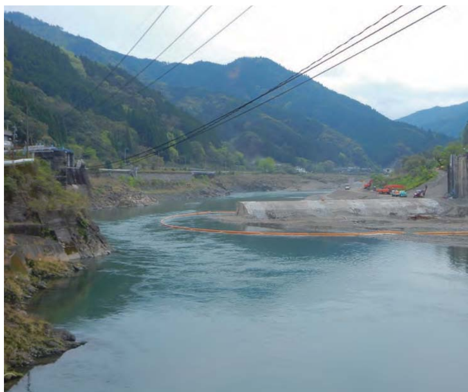
↑ 撤去完了間近の荒瀬ダム 2016年4月10日撮影 写真：つる詳子
