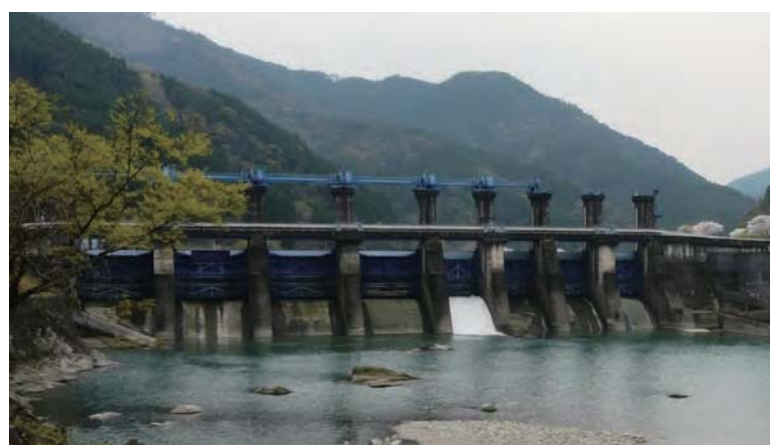
↑ 撤去工事前の荒瀬ダム 2009年3月27日撮影 写真：つる詳子
