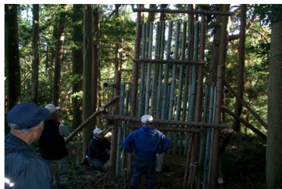
竹と間伐材で作った有害獣捕獲わな
