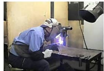
溶接作業技術
