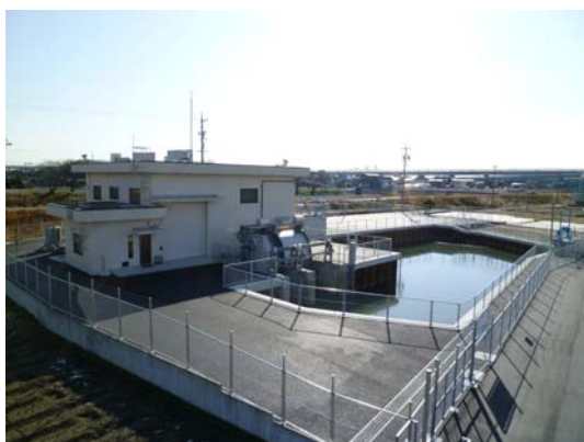
大雨から暮らしを守る排水機場の改修
