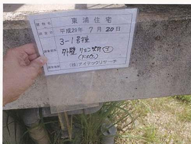
3-1号棟 外壁 リシン吹付③(下地)
