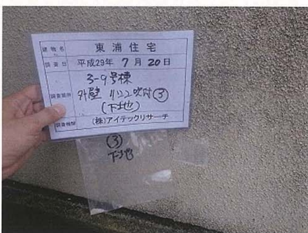
3-9号棟 外壁 リシン吹付③(下地)
