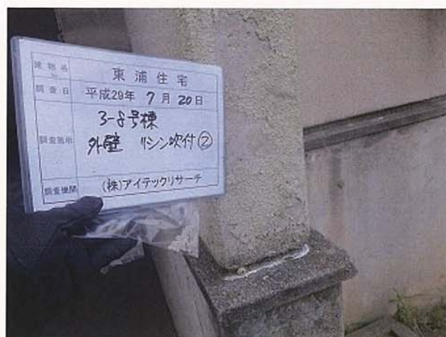
3-8号棟 外壁 リシン吹付②
