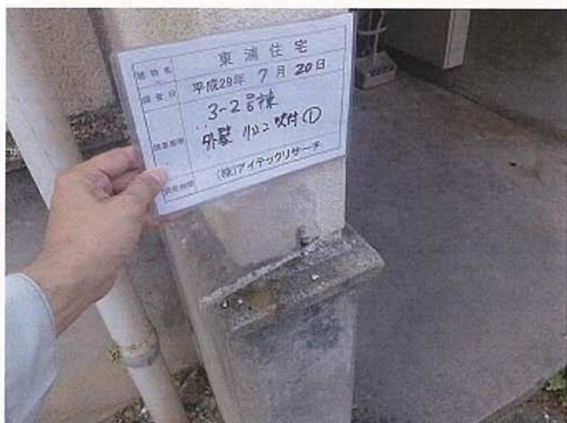
3-2号棟 外壁 リシン吹付①
