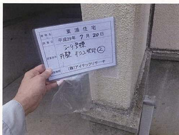
3-9号棟 外壁 リシン吹付②
