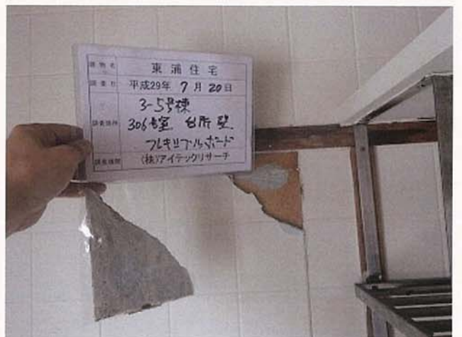
3-5号棟 306号室 台所 壁 フレキシブルボード
