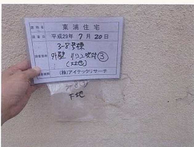
3-8号棟 外壁 リシン吹付③(下地)
