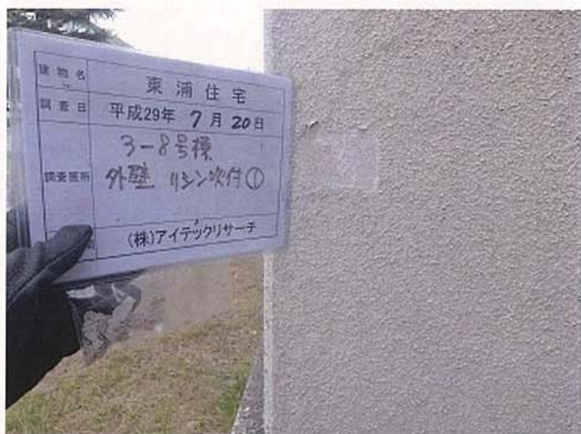
3-8号棟 外壁 リシン吹付①
