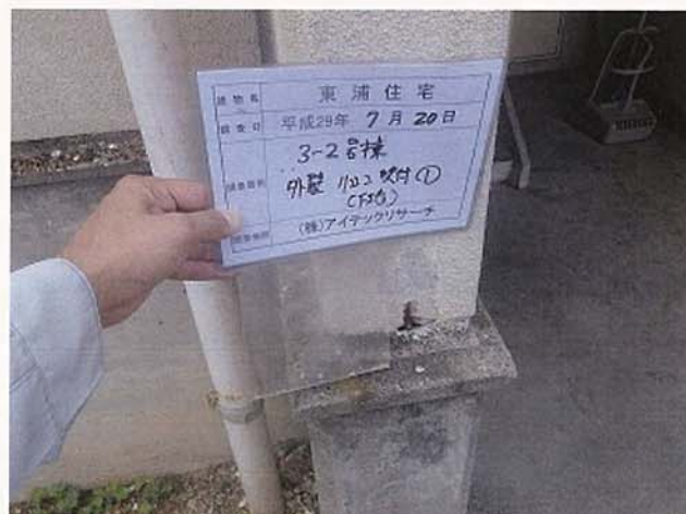
3-2号棟 外壁 リシン吹付①(下地)
