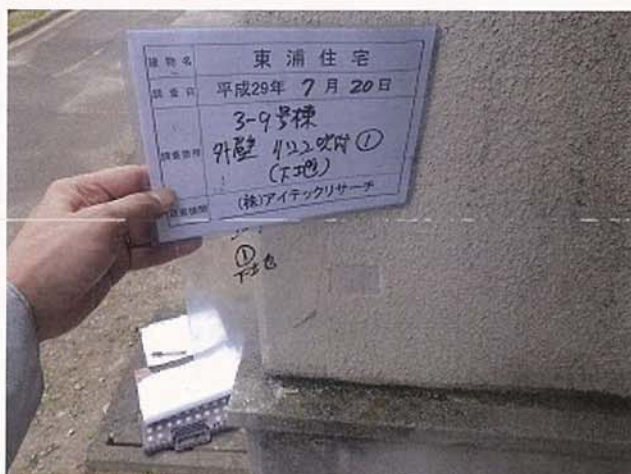
3-9号棟 外壁 リシン吹付①(下地)
