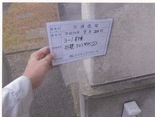
3-1号棟 外壁 リシン吹付②
