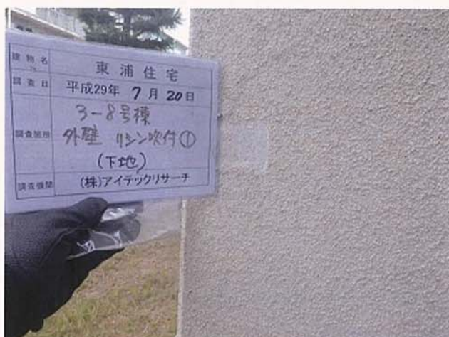
3-8号棟 外壁 リシン吹付①(下地)
