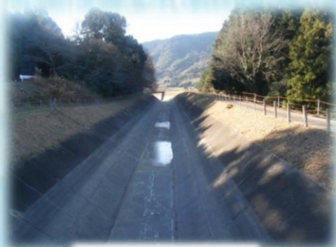
本線水路（改修前）
