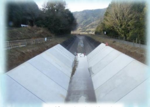
本線水路（改修後）
