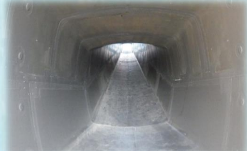
サイホン補強（角形鋼管）
