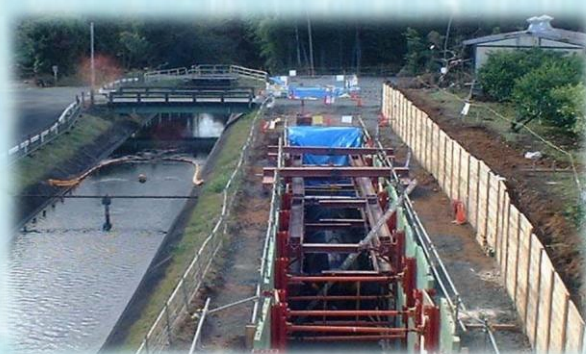
本線水路は通水しながら、先行して併設水路を施工
