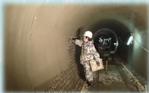
トンネル補強（炭素繊維グリッド工法）
