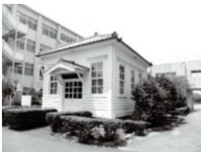
全景（北東から）
