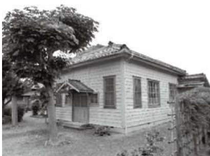
局舎（南西から）
