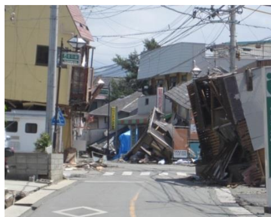
損壊建物（地震）
