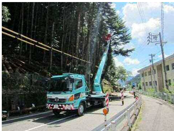
高所作業車による枝払い
