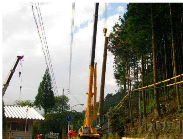
大型クレーンによる吊るしながらの伐採
