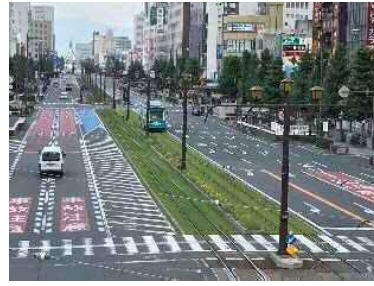
軌道緑化 (豊橋市)
