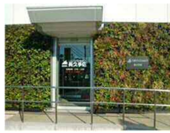
壁面緑化 (長久手市)
