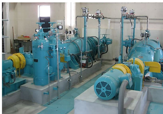
三宅川排水機場
