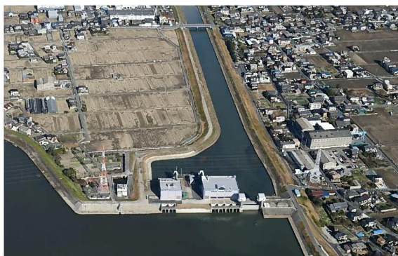
福田川河口排水機場
