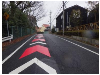
対策後(平成30年2月)
