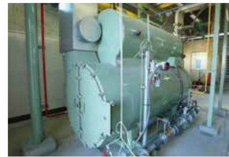
⑥ 循環水加温用ヒータ 消化ガス発電設備の停止または加温熱量不足時に合わせて稼働し消化槽内の汚泥加温に必要な熱量を温水供給することで、消化槽を間接的に加温します。ヒータの燃料は消化ガスと重油の両方とも可能です。
