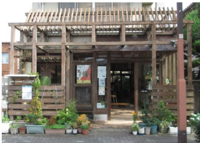
道路から見た「まちの縁側」クニハウス
