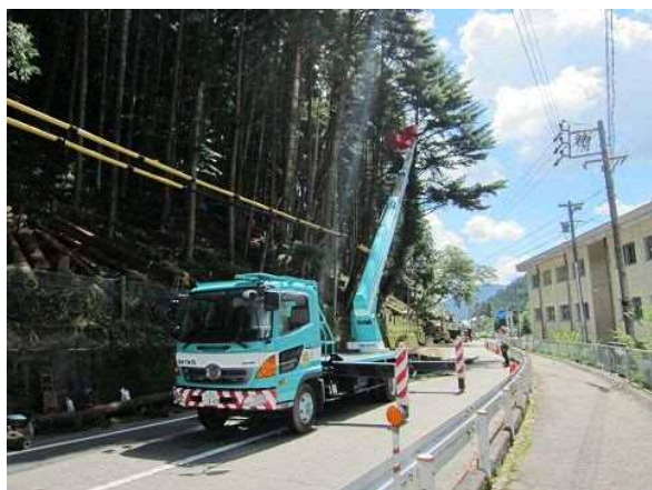
高所作業車による作業
