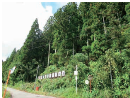
施工後 7 年目（平成 29 年）
