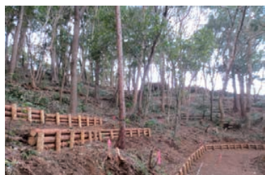
整備前（写真上）、整備直後（写真下）
