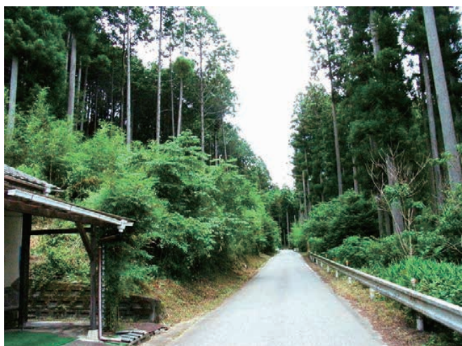
施工後7年目（平成29年）
