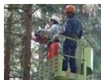
高所作業車による作業
