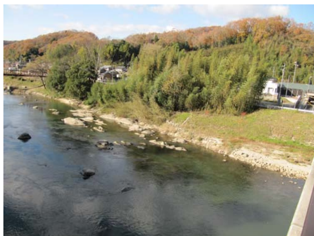
新富国橋と富国橋の間の右岸側 (新富国橋より)
