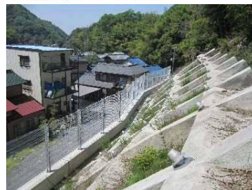
擁壁工、法枠工 (上町区域：春日井市)
