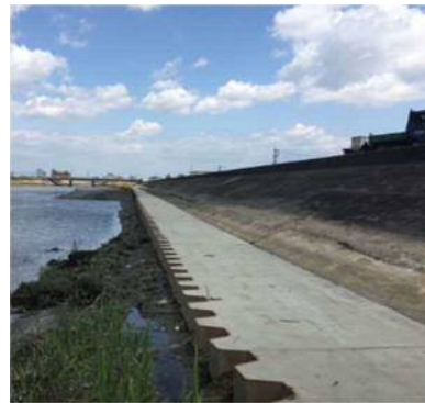
猿渡川の耐震工事状況 (矢板打設)
