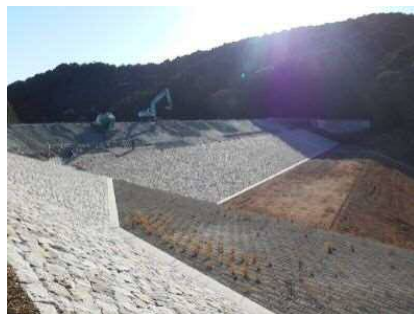
ため池の耐震工事状況
