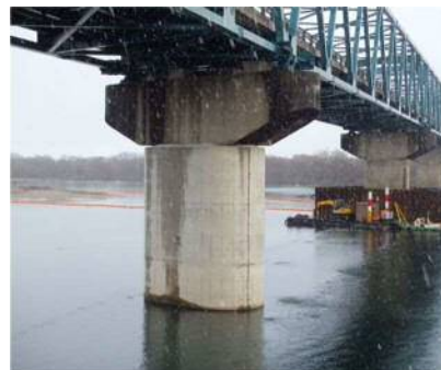
(一)大垣江南線 (尾濃大橋) 橋脚の耐震補強 (一宮市)
