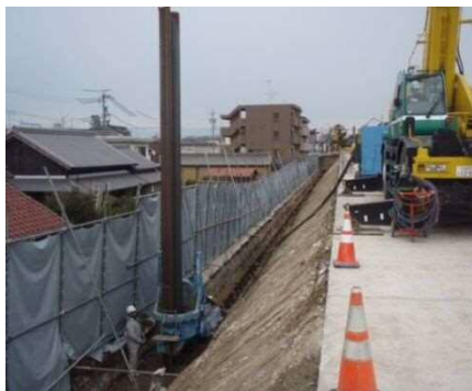
天白川の耐震工事状況 (名古屋市)
