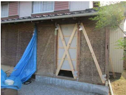
耐震改修工事イメージ
