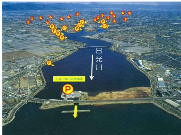
ゼロメートル地帯を守る農業用排水機場
