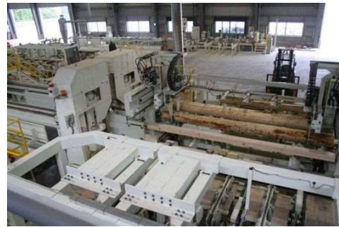
豊田市に建設された製材工場(内部)
