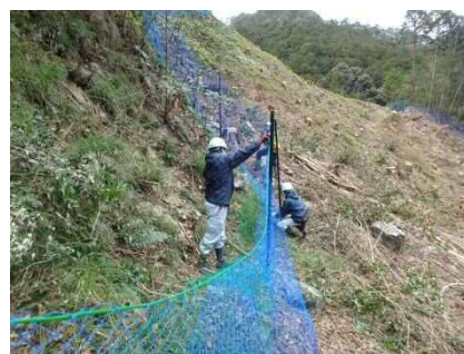
獣害防止柵の設置
