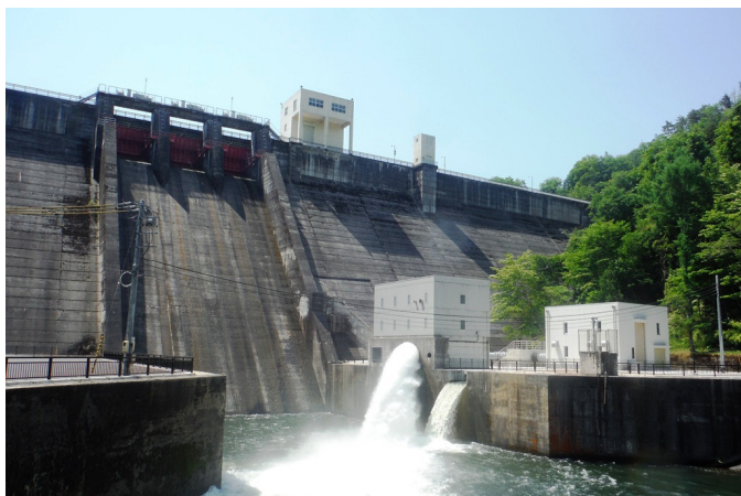
羽布ダム小水力発電所
