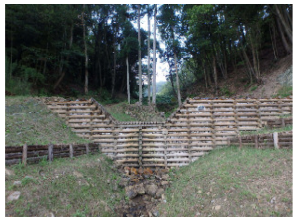
溪流に設置された木製の床固工
