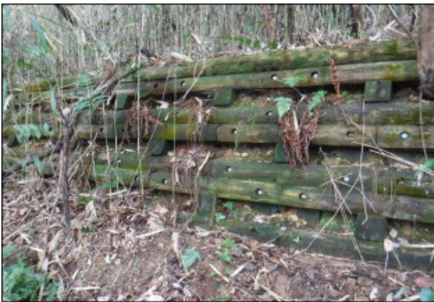
写真－1 ウッドブロック設置状況
