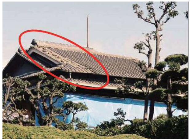
煉瓦以外の瓦もずれが著しい
