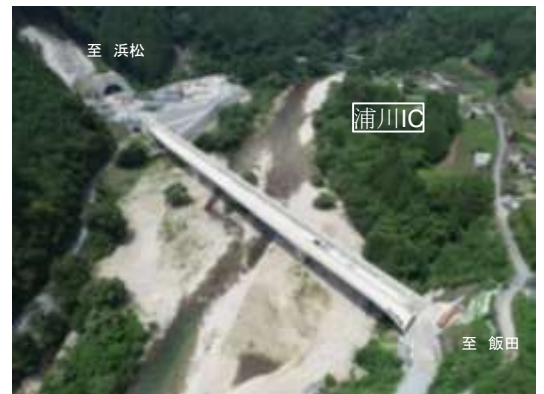
【佐久間道路の工事状況（2018.7撮影）】
