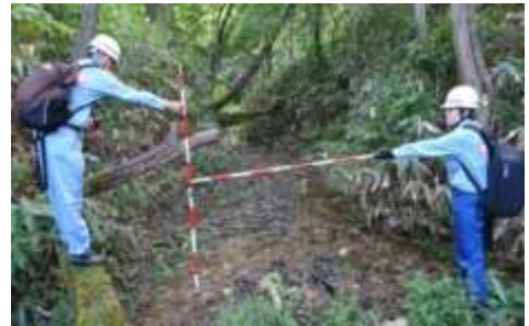
【土砂災害危険箇所調査】 (北海道三笠市)
