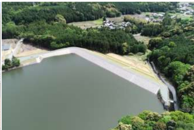
【 整備完了状況 】
