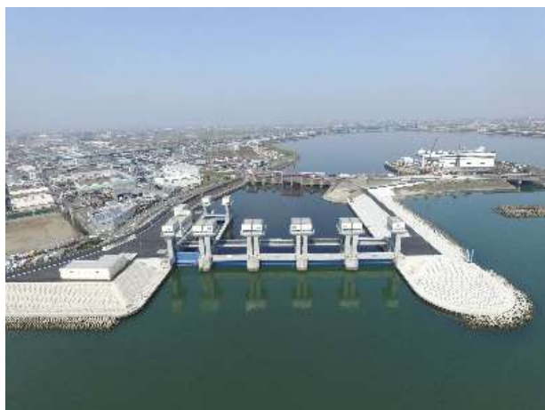
日光川水閘門（平成29年度完成）
