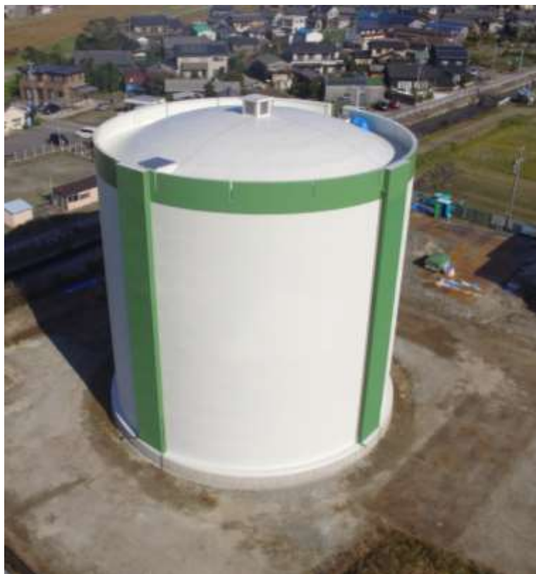
【西尾広域調整池1池】
