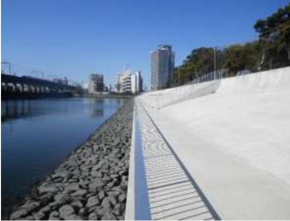
【防潮壁の地震・津波対策（鴨浦地区）】
