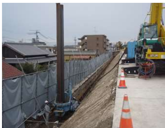
天白川の耐震工事状況
