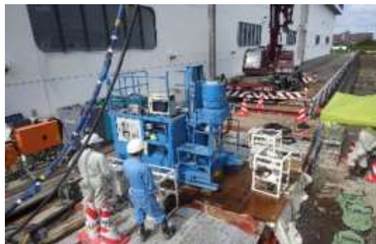
基礎耐震化対策(地盤改良工)実施状況
