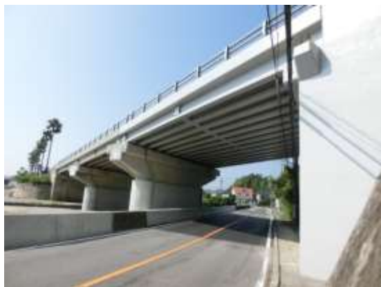
【(一) 富好新田宮崎鳥羽線・新宮崎橋】
