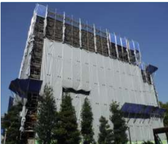
【愛知県議事堂外壁等改修工事】
