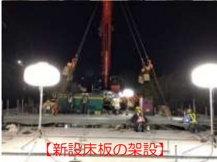
【新設床板の架設準備】
