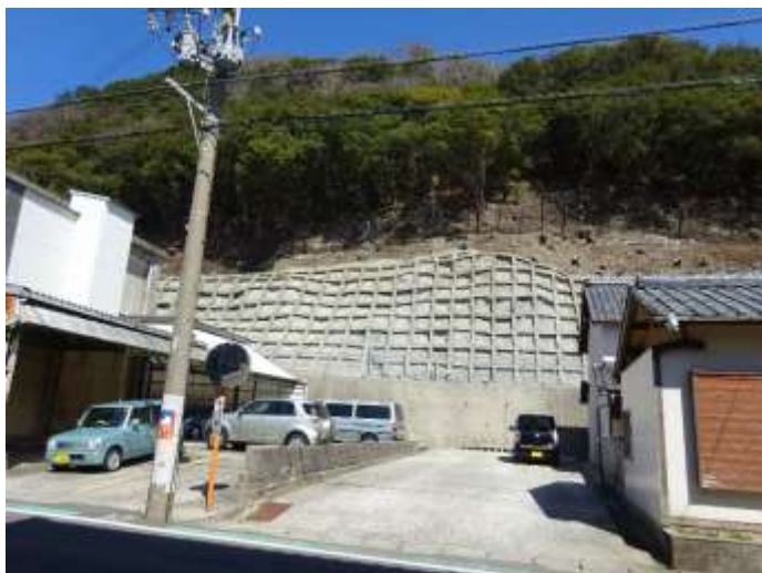
【 治山施設の整備 】
