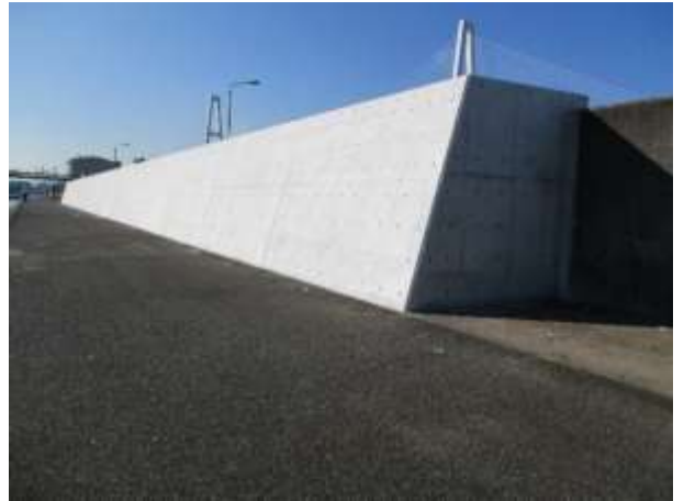
【防潮壁の地震・津波対策（潮見地区）】
