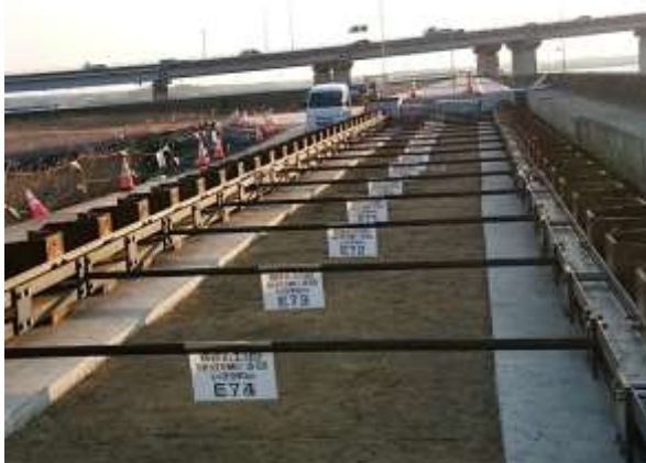
豊橋海岸の耐震工事状況
